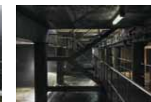
SUARISTA Aliviadero Natahoyo, Gijón
